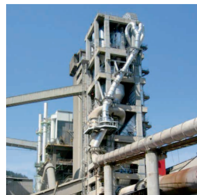
ЦЕМЕНТНЫЙ ЗАВОД, ИСПАНИЯ ПЕЧЬ С ТЕПЛООБМЕННИКОМ
