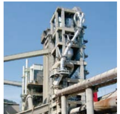
ZEMENTWERK, Spanien WÄRMETAUSCHEROFEN
