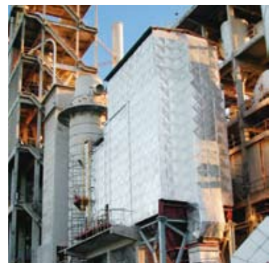
ZEMENTWERK, Brasilien WÄRMETAUSCHEROFEN
